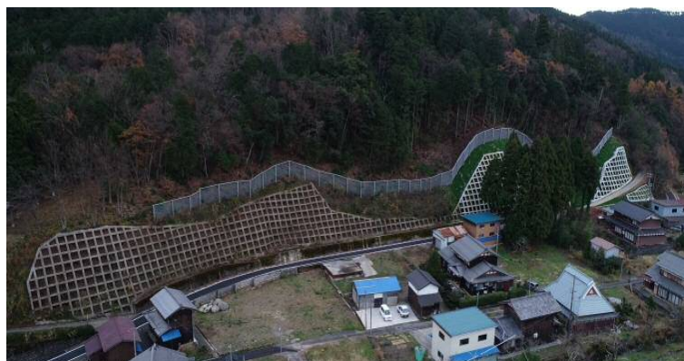
下余呉地区の急傾斜地崩壊防止施設
