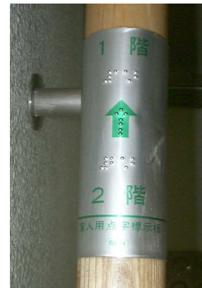
手すりには、点字表示が必要です
