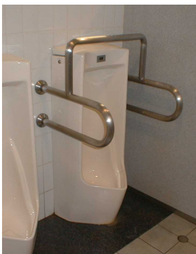
床置き式小便器の両側に手すりがついていれば、だれでも安心して利用できます
