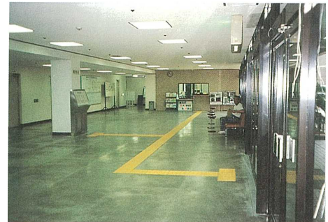
この施設では、出入口から案内板と受付まで視覚障害者誘導用ブロックが敷設されています
