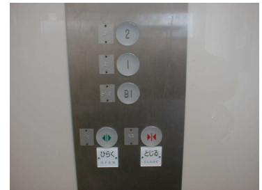
この操作盤は、点字と浮き文字の両方による表示がされています
