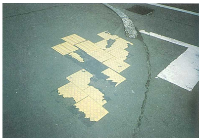
定期的な維持管理により、視覚障害者誘導用ブロックの破損を補修する必要があります
