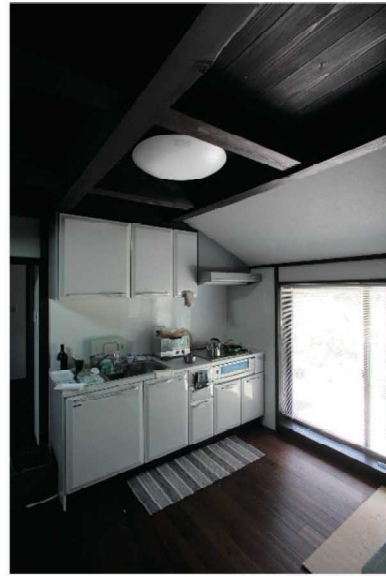
右：改修後のキッチン。壁を取り払ってアルミサッシを入れ、室内を明るくした。
