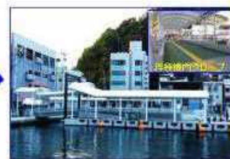
バリアフリーに配慮された浮桟橋
