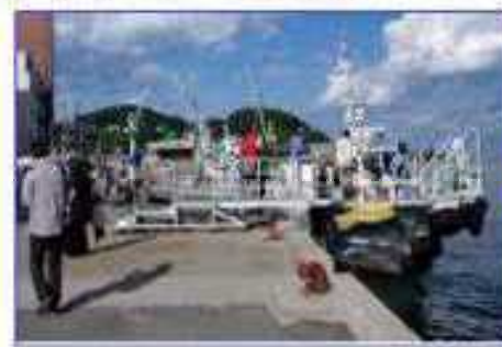
浮桟橋整備前の係留施設
