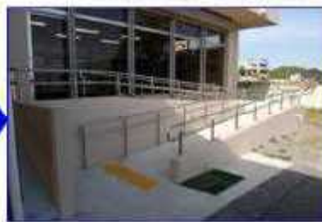
スロープ・手摺等が整備され、円滑な移動が可能である状態
