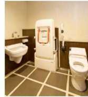
・壁掛け式大型ベッドのある 便所
