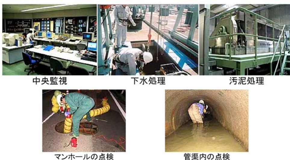
図 3-2-44. 下水道施設の管理状況
