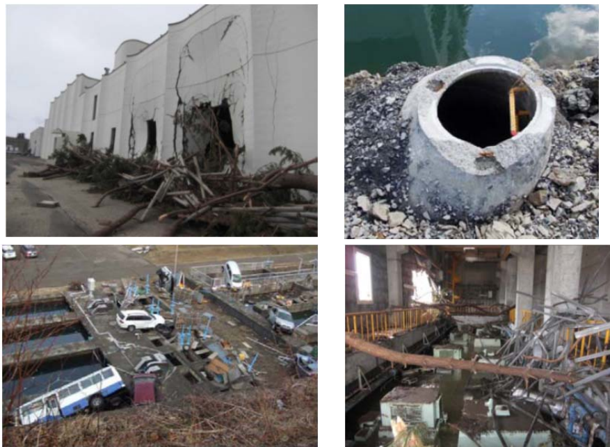
図 3-2-28. 東日本大震災における下水道施設の津波被害の状況
