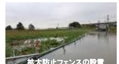
拡大防止フェンスの設置
