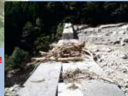
砂防えん堤で土砂や流木を捕捉
