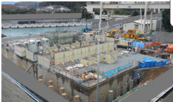
〔竜巻飛来物対策設備設置前〕
