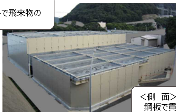
〔竜巻飛来物対策設備設置後〕
