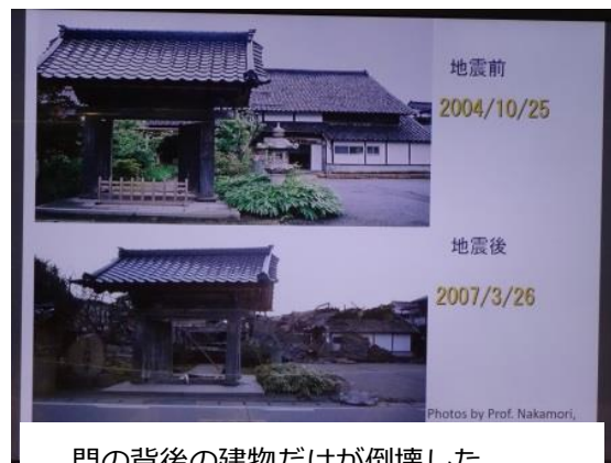
門の背後の建物だけが倒壊した
