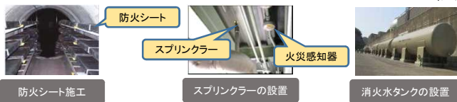
防火シート施工
