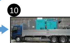
電源車【5台/2ユニット】
