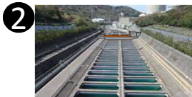
取水路防潮ゲート
