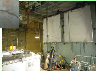
解体終了(H26.09.04)
