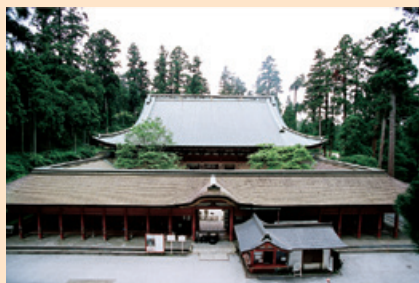
写真T-2 延暦寺根本中堂 (大津市)
