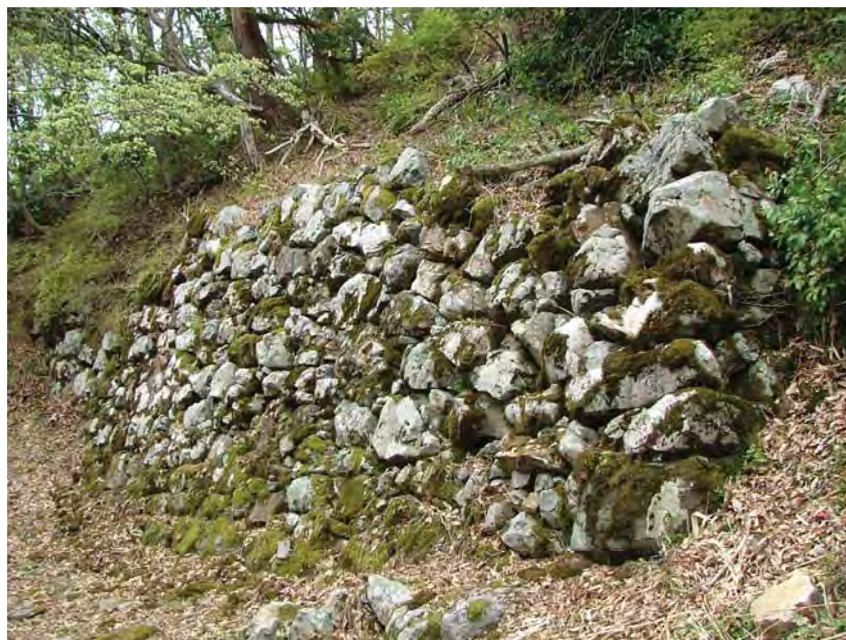
小谷城山王丸大石垣（北東から）
