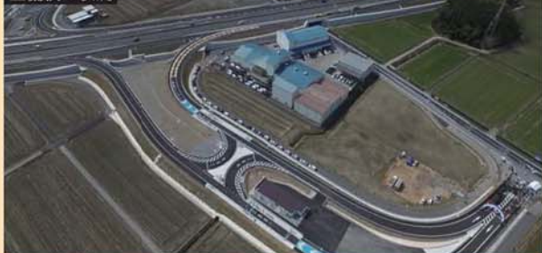
整備後の状況
