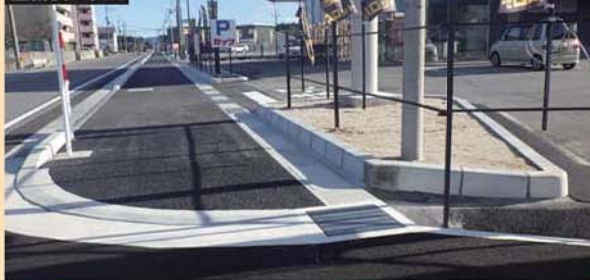
整備後の状況
