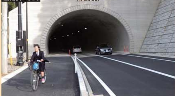
整備後の状況
