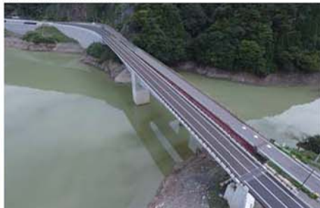
現在の進捗状況-2
