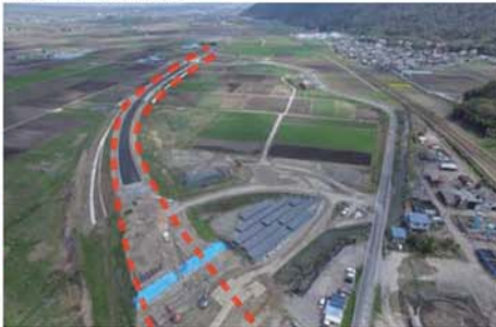
現在の進捗状況-2
