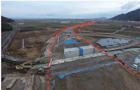
現在の進捗状況-1
