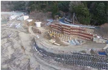
現在の進捗状況-1
