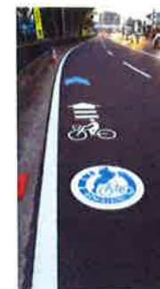
自転車走行空間整備 (矢羽根による路面標示)
