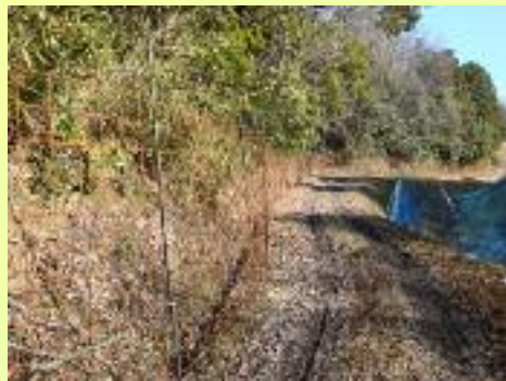
写真左：山から動物が侵入しないよう 高さ4mの鉄柵を設置 写真右：畑への侵入を防ぐための柵
