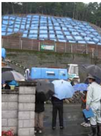
(急傾斜工事現場)
