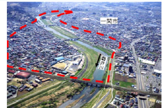
当初想定された磐井川下流域の避難対象エリア (天然ダム(河道閉塞)から概ね20Km)
