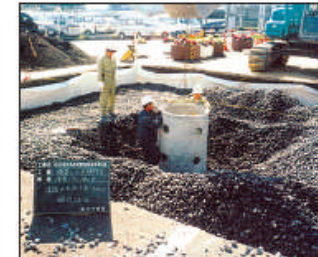
大型浸透ますの施工状況
