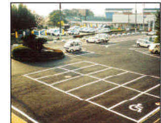
完成した透水性舗装
