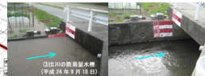
姉川・出川 簡易量水標の設置
