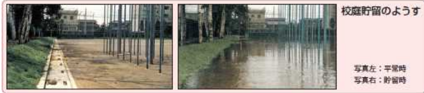
□ グランドに周囲堤を設けた窪地貯留と地下貯留槽の併用：富士市立岩松北小学校（静岡県富士市）
