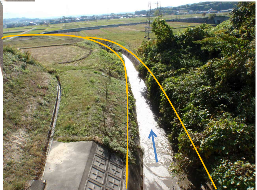
えん堤より下流を望む
