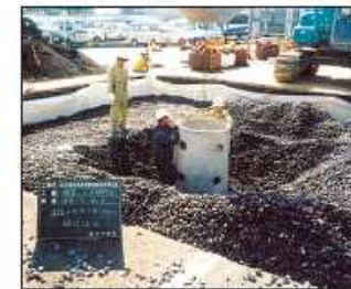
大型浸透ますの施工状況
