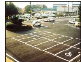
完成した透水性舗装
