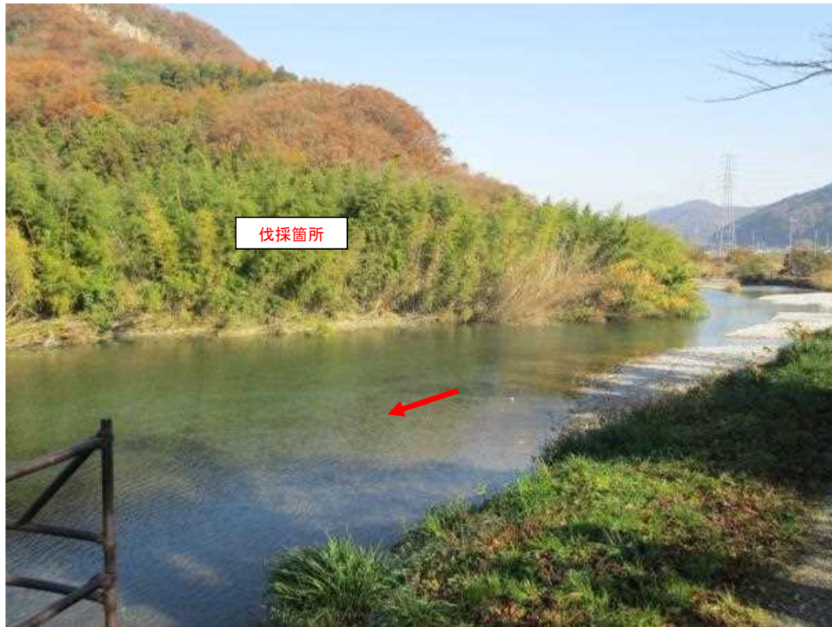
米原市川南地先(天の川合同地区樋門上流)
