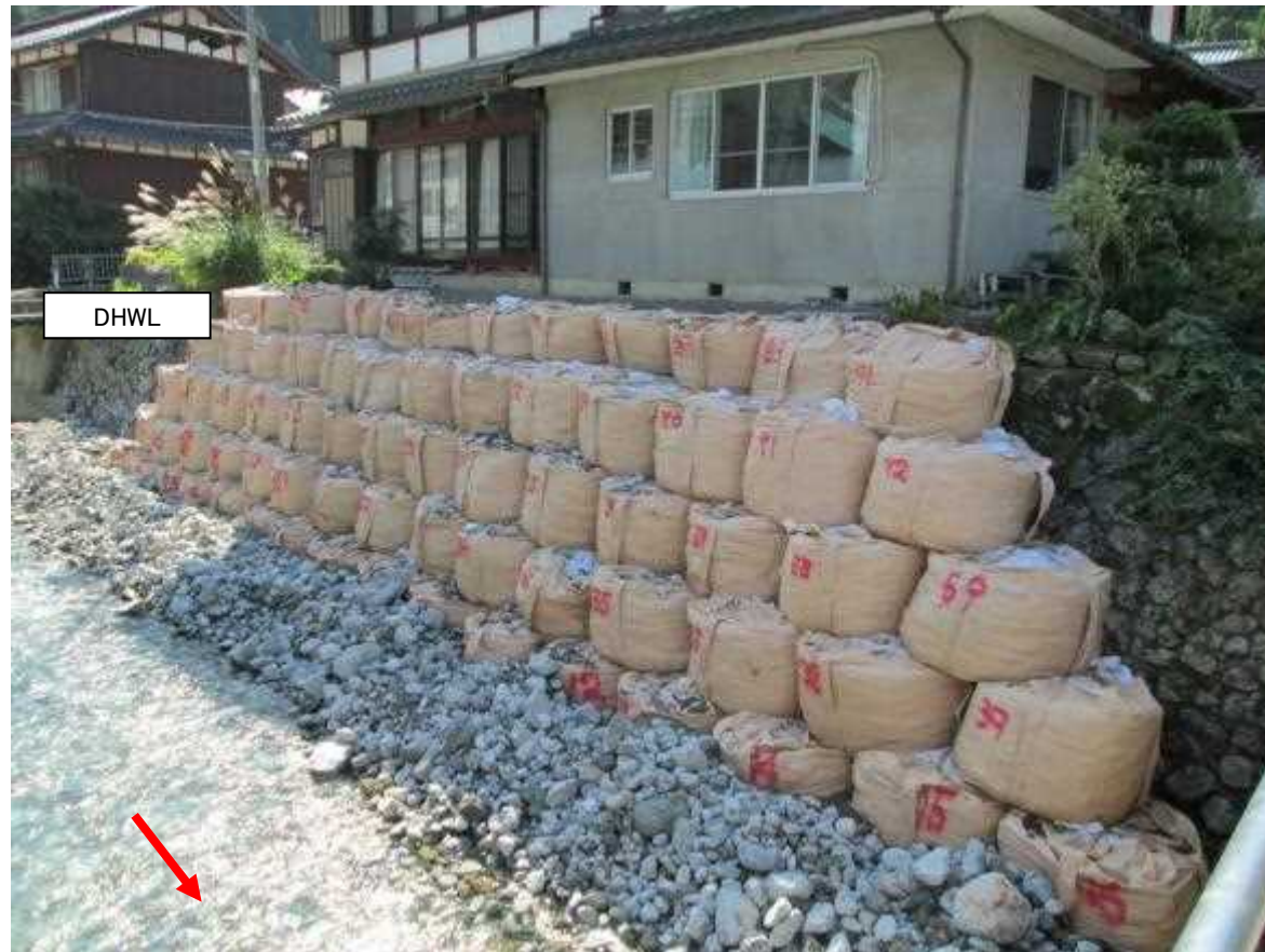
米原市上丹生地先 応急復旧工事 L=13m 大型土のう積工
