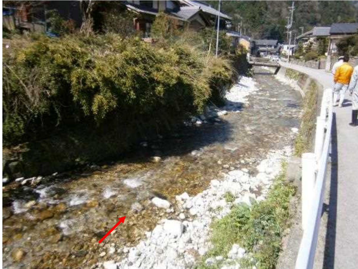
米原市上丹生地先 宮前橋下流 (平常時)
