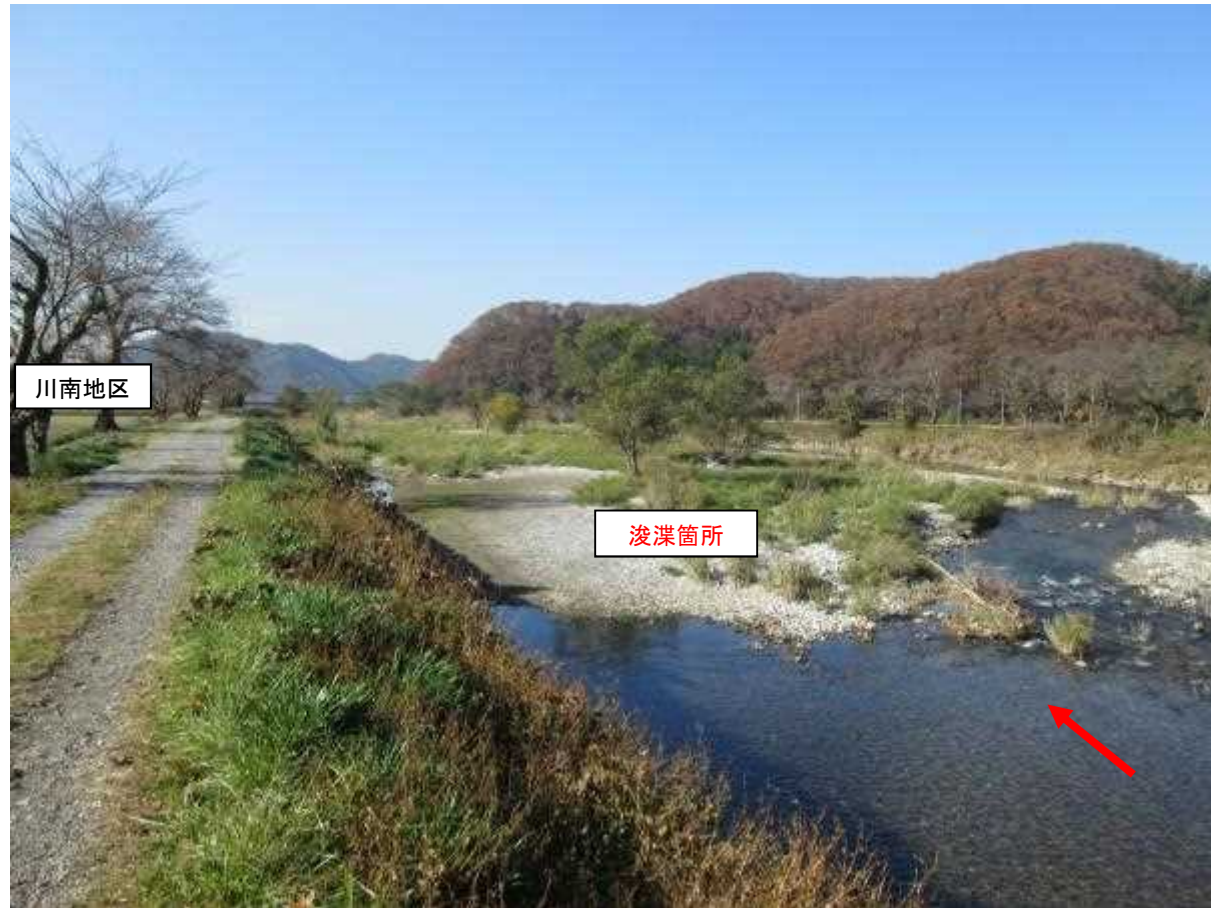
米原市川南地先(天の川合同地区樋門下流)
