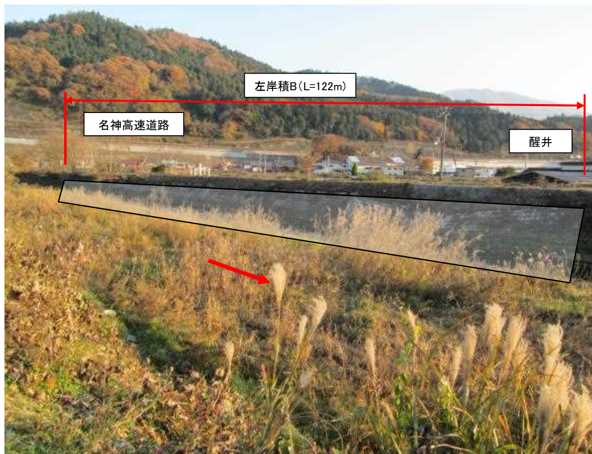
米原市醒井地先 左岸L=122m H=5.9m (9月15～16日の台風18号により被災)
