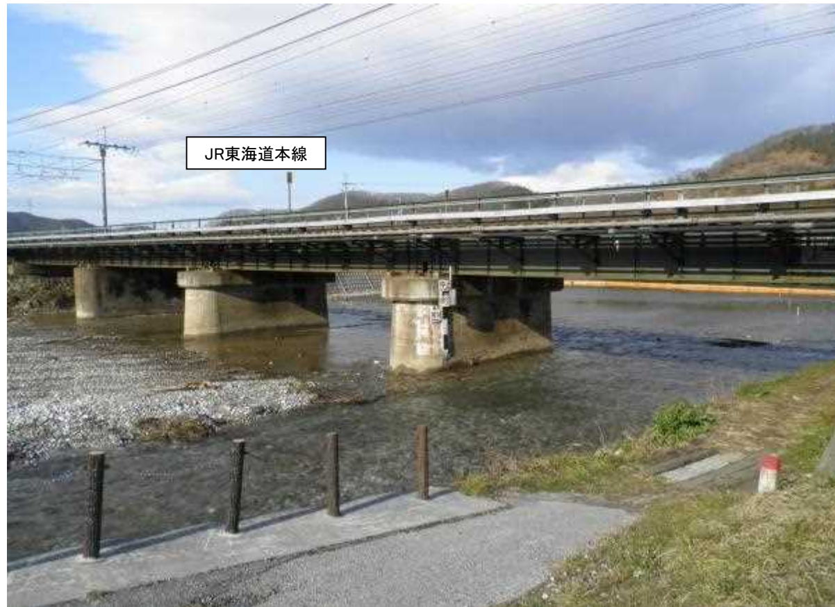
米原市醒井～枝折地先 完了イメージ写真 (平成24年2月完了時)
