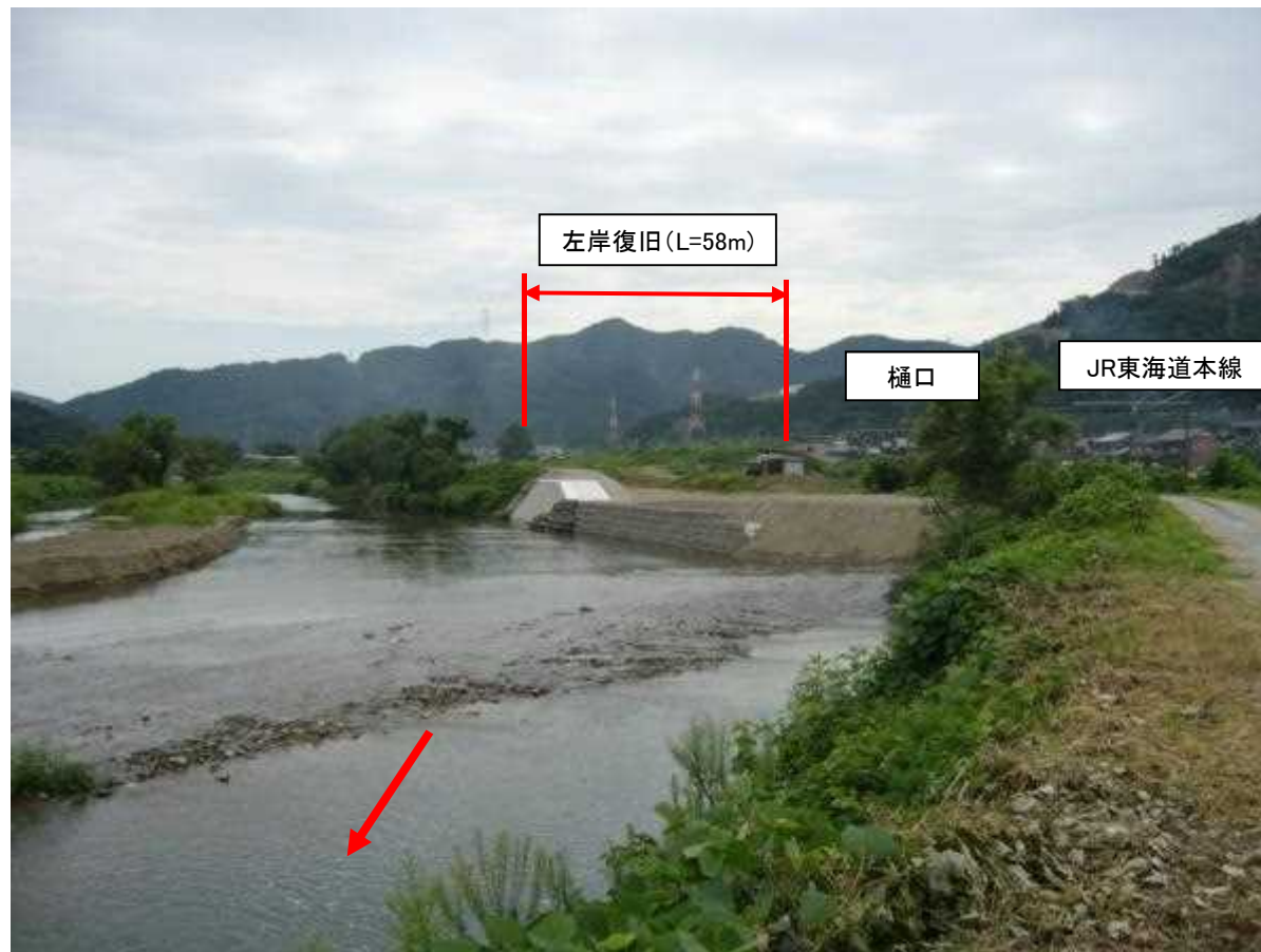
米原市樋口地先(工事完了写真)
