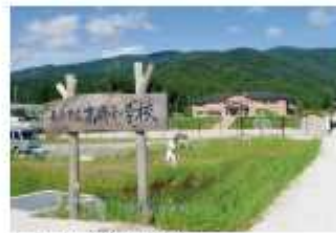
▲高時小学校(長浜市) ビオトープ兼用の雨水貯留施設
