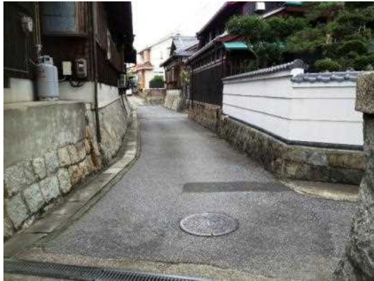
嵩上げされた住宅
