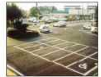
完成した透水性舗装
