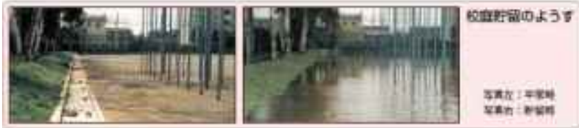
□ グラウンドに掘削場を設けた掘込貯留と地下貯留槽の併用：富士市立岩松北小学校（静岡県富士市）
