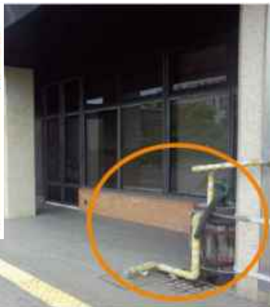
▲滋賀県南部総合庁舎(草津市) 玄関にも雨水貯留タンクを設置しています
