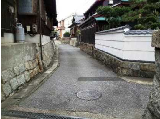
嵩上げされた住宅
