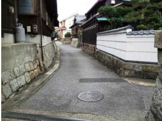
嵩上げされた住宅
