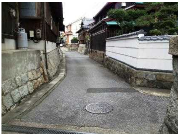
嵩上げされた住宅
