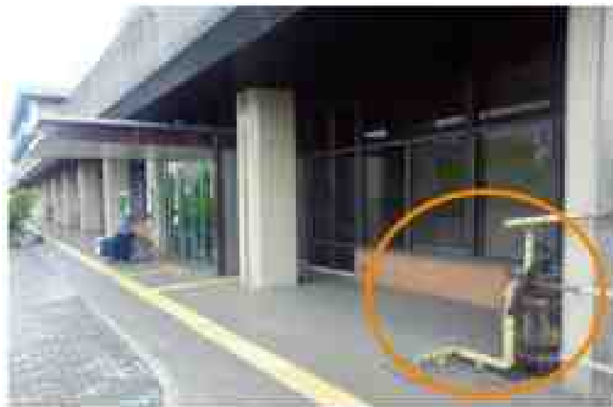
▲滋賀県南部総合庁舎(草津市) 玄関にも雨水貯留タンクを設置しています
