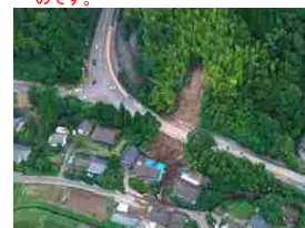
急傾斜地崩壊危険箇所
