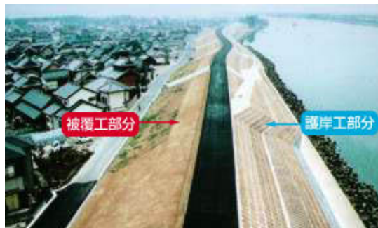
雲出川(香良洲町)のフロンティア堤防 (三重河川国道事務所HP)
