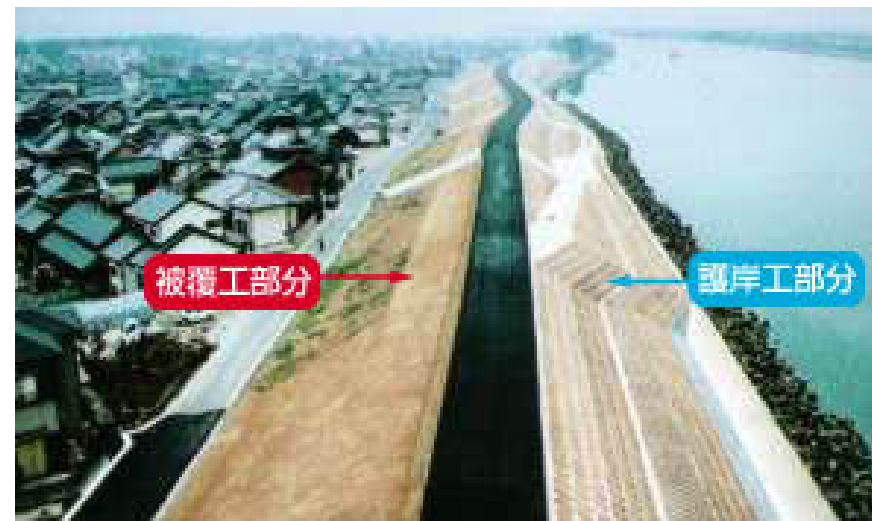
雲出川(香良洲町)のフロンティア堤防 (三重河川国道事務所HP)
