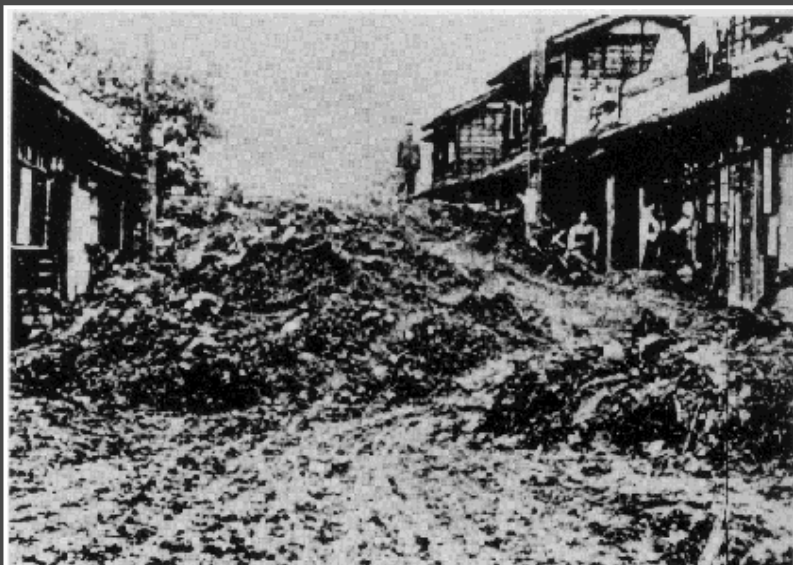
中通りに堆積した土砂の山（浜松町）
