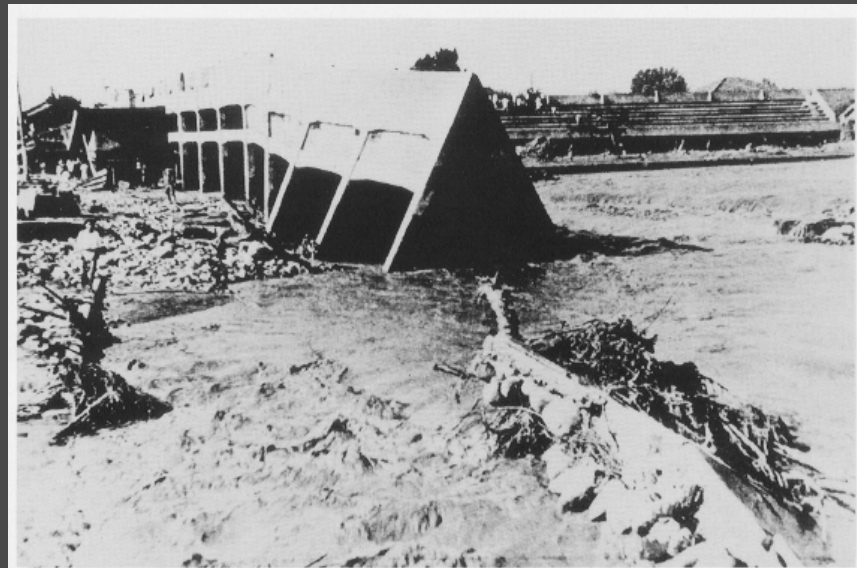
破堤した新川グラウンドのスタンド（稲荷町）
