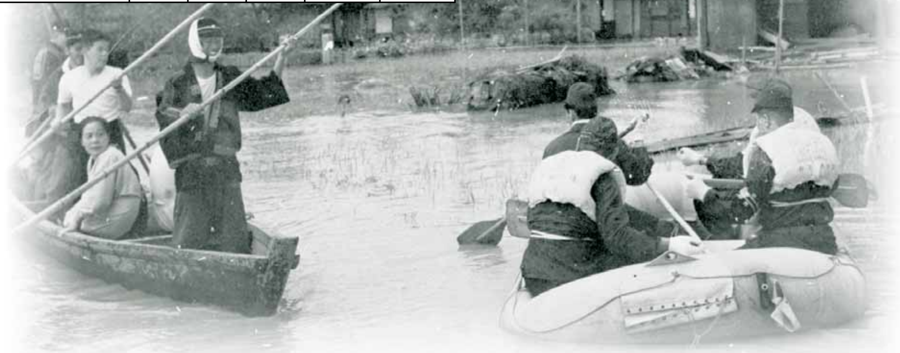
昭和34年伊勢湾台風による浸水状況(野洲市小南)
