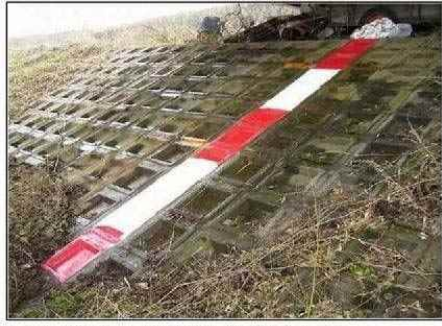
(b)馬渡橋左岸護岸部(橋梁下)
