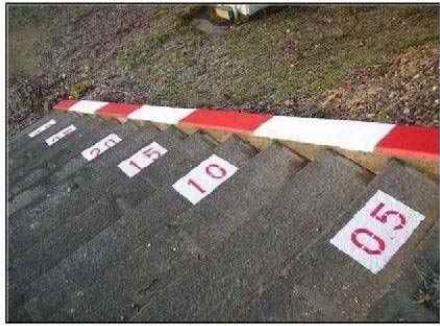
(c)馬渡橋下流グラウンド階段スロープ
