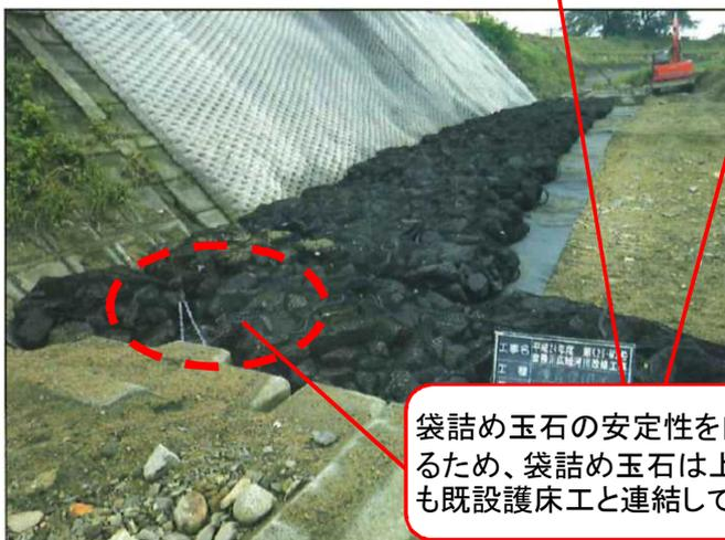
袋詰め玉石の安定性を向上させるため、袋詰め玉石は上下流とも既設護床工と連結している。
