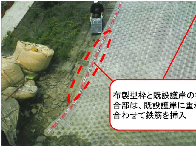
布製型枠と既設護岸の接合部は、既設護岸に重ね合わせて鉄筋を挿入
