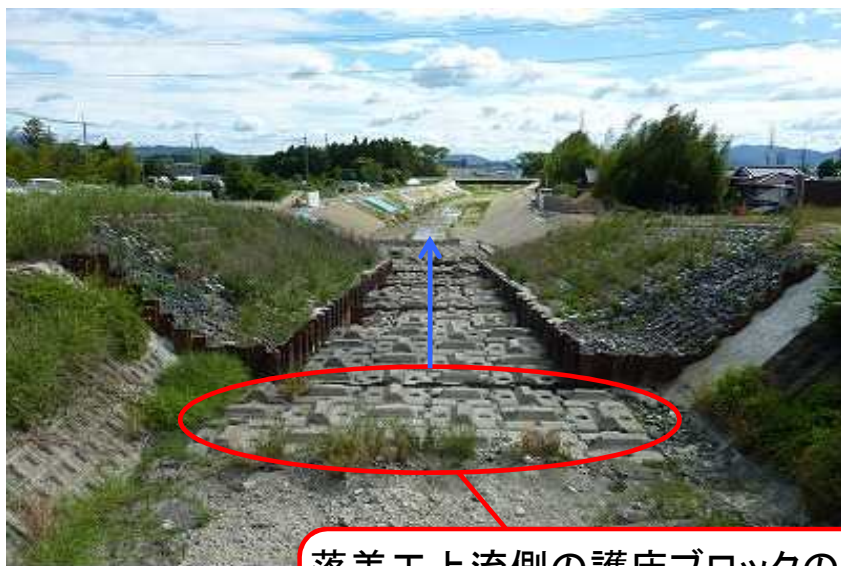
落差工上流側の護床ブロックの安定性について、敷設状況と出水時流況に基づき検証を実施
