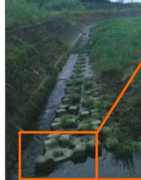
上流湾曲部の護床ブロック
