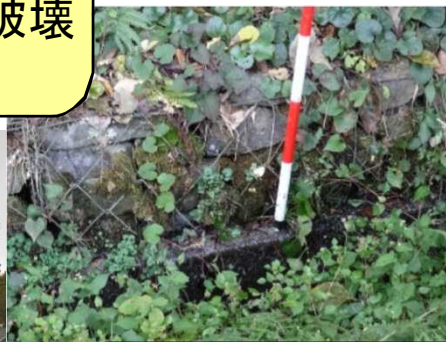
野田橋上流左岸にはカゴマットが設置されており、常時漏水が確認されている
