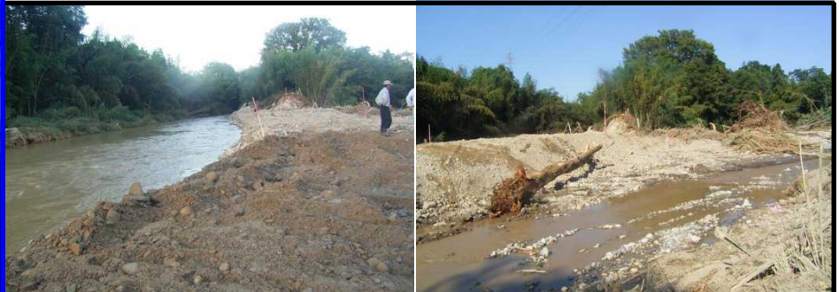
瀬替え作業完了後の河道内(左)と堤内地(右)
