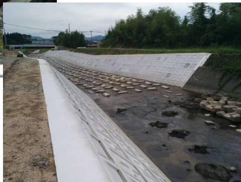
金勝川復旧後写真
