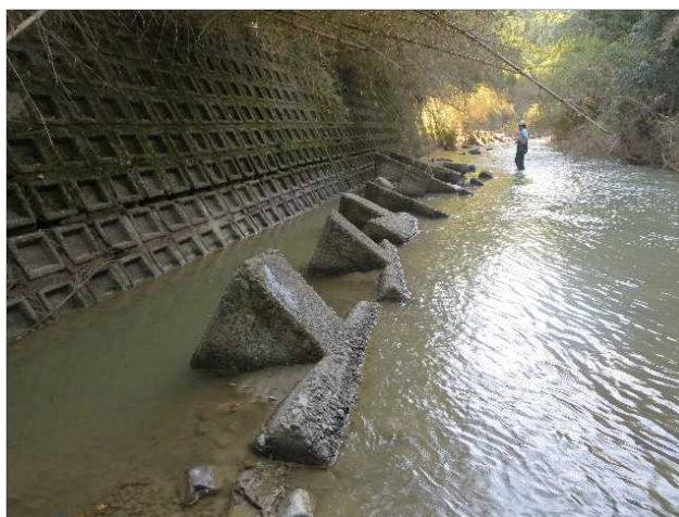
図 ブロックのサイズ・傾きの角度から推定される河床低下量
