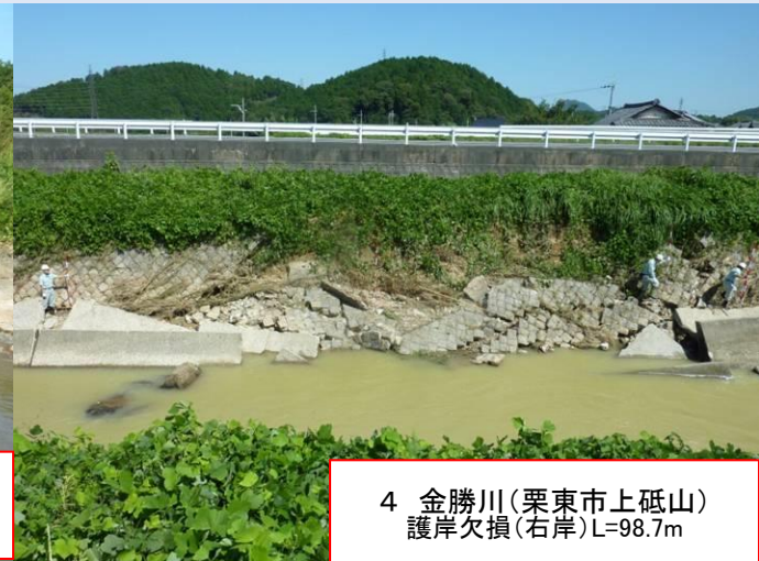
2 金勝川(栗東市下戸山) 護岸欠損(両岸)L=100m
