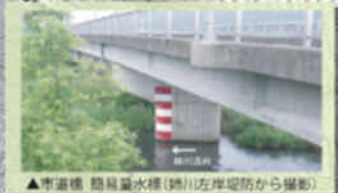
▲市道橋 簡易量水橋(姉川左岸堤防から撮影)
