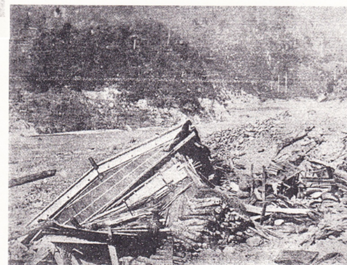
写真5-1 北十津川村大字長殿 流失・倒壊家屋
