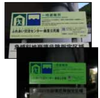
蓄光標識(夜間に光る材質)を設置した例
