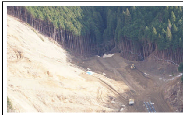
埋め立て完了状況（12月20日）
