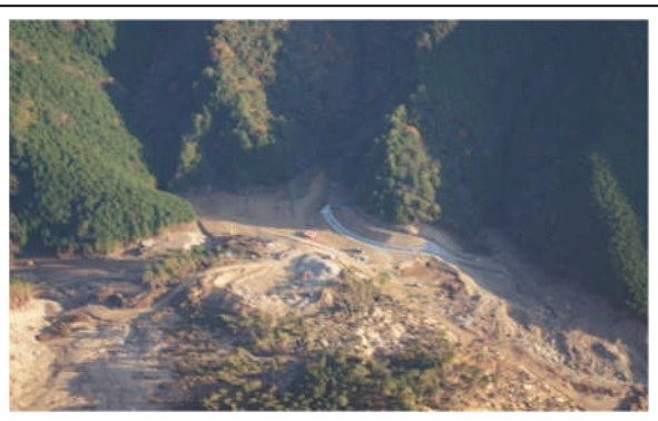
埋め立て完了状況（12月5日）
