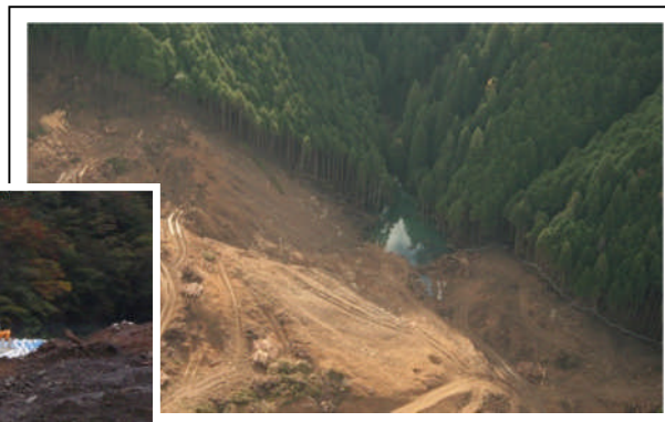
河道閉塞箇所湛水状況（10月26日）
