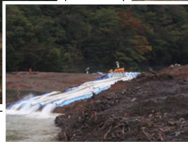
ポンプ排水状況
