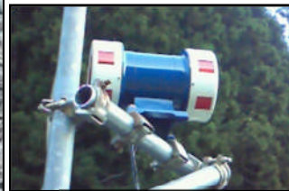
サイレン設置
